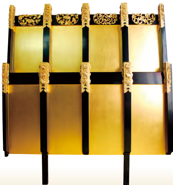
鉾鋸屋根の一部
